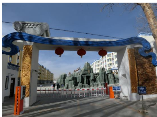
写真 3-1 都市型A定住区の建設状況
