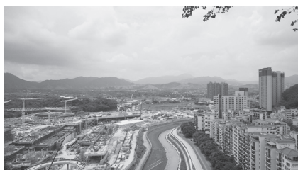
写真7 建設中の蓮塘口岸
