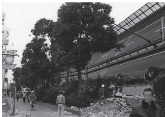
写真1 深江本町阪神高速倒壊現場(1995年1月18日)
